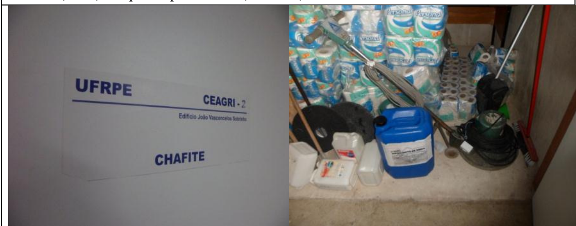
Chafite (shaft) no pavimento térreo armazenando material de limpeza
