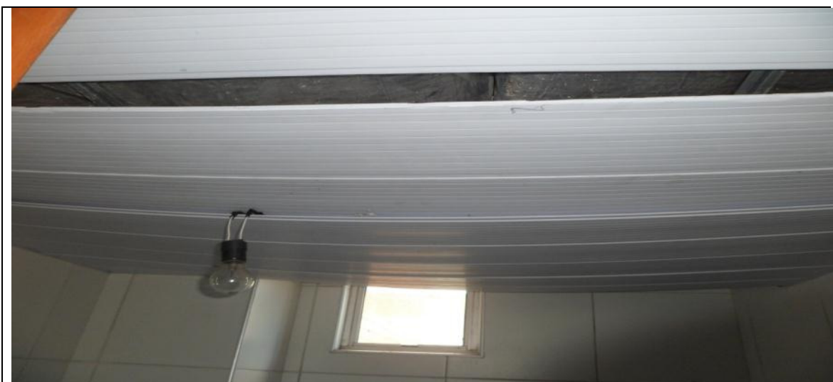
Banheiro feminino no térreo para portadora de necessidades especiais
