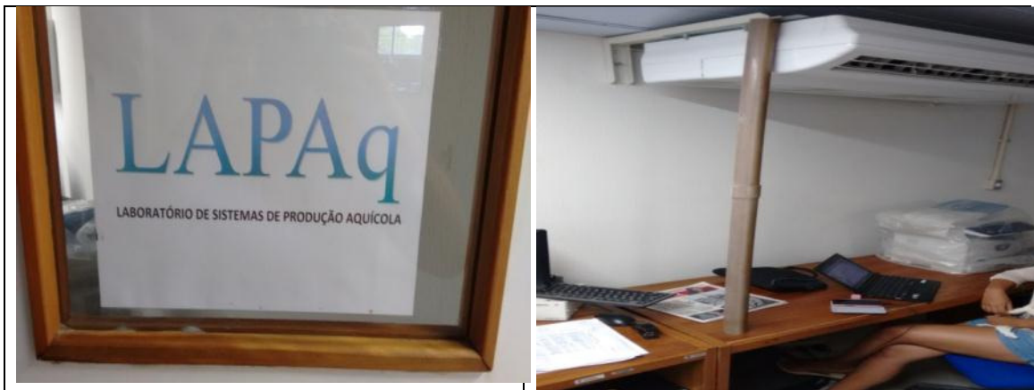
Equipamento de ar condicionado inadequadamente instalado, com apoio em tubo de PVC, no Laboratório de Sistemas de Produção Aquícola
